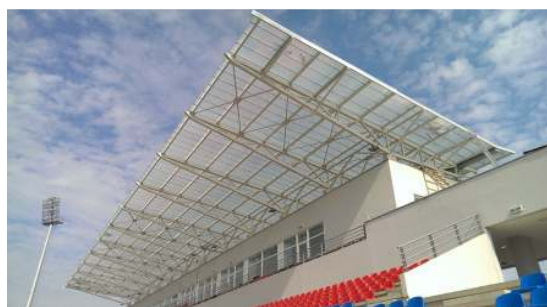
Kuća fudbala, Stara Pazova - nadstrešnica
