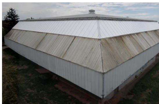
SC Šid - polikarbonatna fasada
