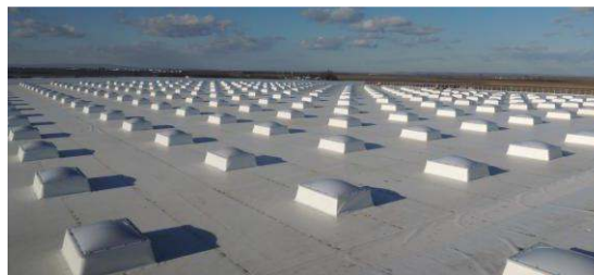
Lidl, Stara Pazova - ugradnja svetlosnih kupola
