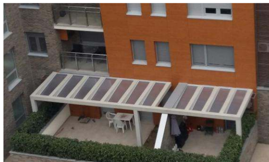
Blok A, Beograd - nadstrešnice
